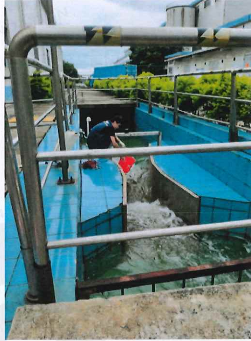
造纸废水排放口
